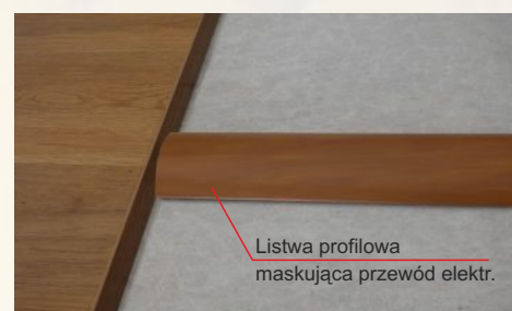
Rysunek przedstawia doprowadzenie zasilania do płyty
